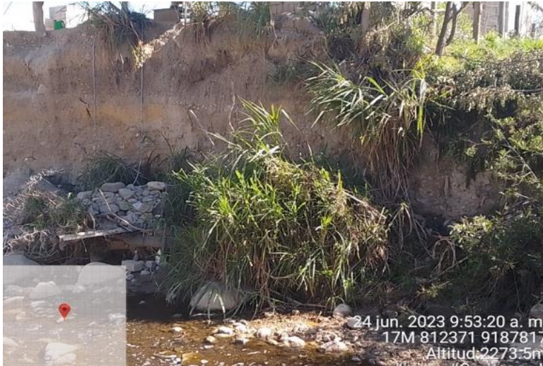
FOTO 04 : En la vista se observa la margen derecha del río, de material suelto próximo a erosionar debido a su conformación de material suelto
